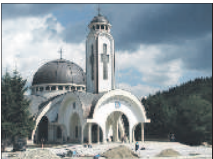
Собор в честь св. Висариона Смолянского, в алтаре которого замурована часть мощей св. мц. Марины. Смолян. Болгария
