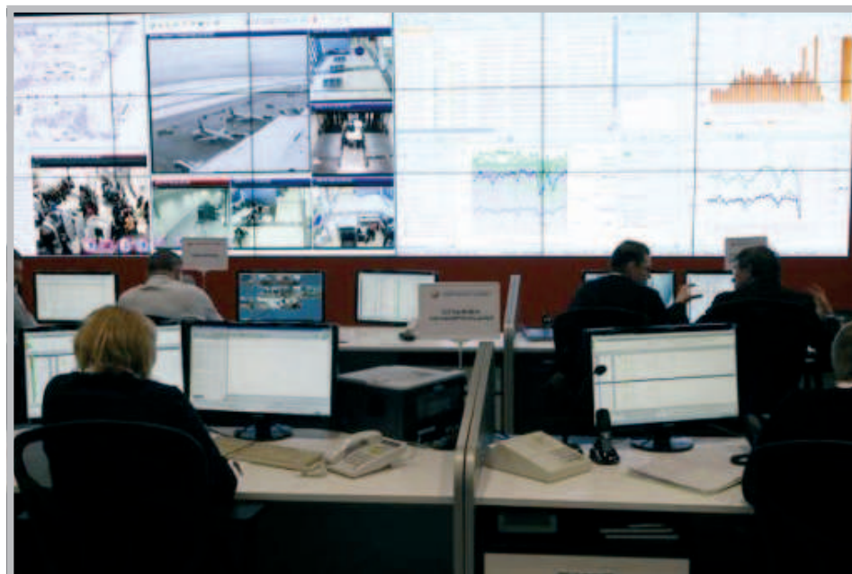
Година след "ледения дъжд", който през 2010-а буквално обърка работата на авиаторите, в Шереметиево бе открит Център за управление на летището. Той позволява да се организира съвместната работа на всички участници в процеса на обслужване на самолетите, пътниците и багажа, да се координират действията на всички подразделения на летището включително и при възникване на кризисни ситуации, в реално време да се следи и управлява обстановката на територията на летището
