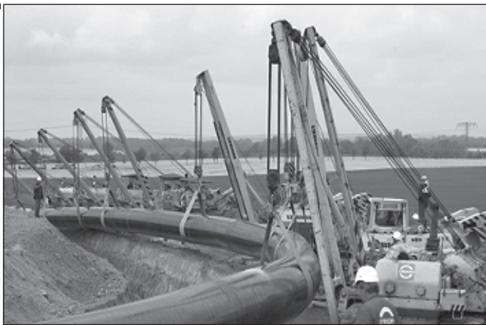
Строителство на разклонението OPAL
