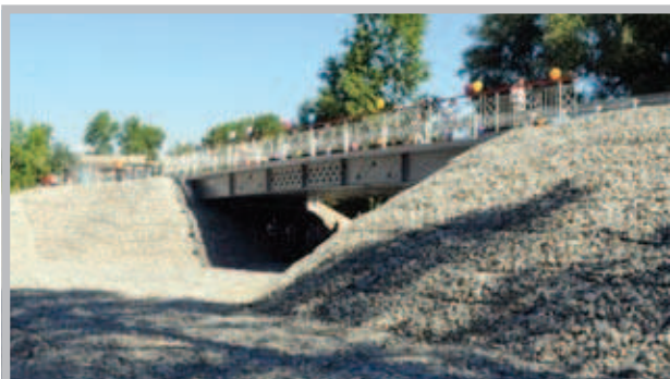
В село Сосновка (Новосибирски район) бе въведен в експлоатация особен мост. За основните носещи елементи е използван многослоен стъклопластик. Новите полимерни композитни материали са създадени през XX век за нуждите на аерокосмическата техника и се оказали конкуренти на редица строителни материали поради по-голямата си здравина, твърдост и устойчивост на корозия. По някои характеристики тези материали превъзхождат стоманата, при условие, че са пет-седем пъти по-леки от нея. През 2004 г. е построен първият мост от "космически" материали, но той е пешеходен, а в Сосновка е първият, предназначен за автомобилно движение
