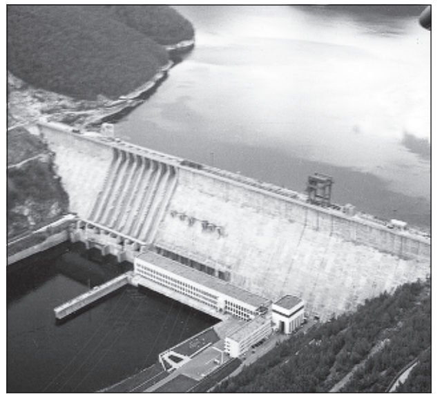
Всемирный банк дал своё согласие на строительство Рогунской ГЭС на реке Вахш в Таджикистане. Об этом сообщил заместитель главы Согдийской области Жумабай Сангинов на пресс-конференции в Худжанде, информирует Gezitter.org 15 августа с. г. Высота плотины Рогунской ГЭС - 336 м., строительство было запланировано еще во времена СССР
