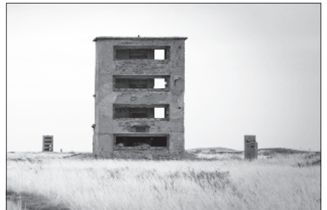
В этих сооружениях находилась измерительная аппаратура
