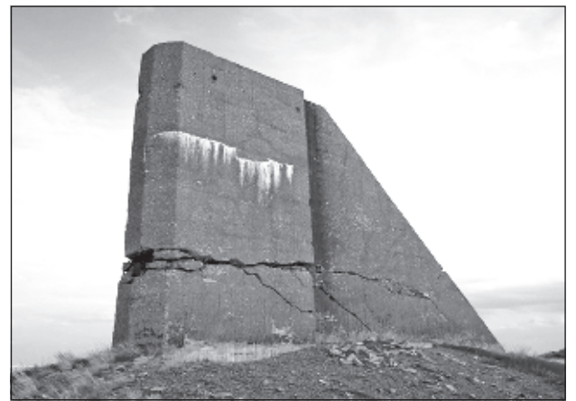
Это зловещее сооружение называется "гусь". С помощью таких железобетонных конструкций измеряли ударную волну ядерного взрыва
