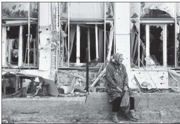
Разрушенное здание в Первомайске (Луганская область), 28 сентября 2014 года
