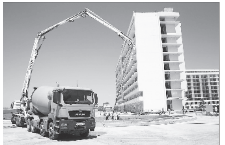
Завършва строителството на технополиса "Ера". Министърът на отбраната Сергей Шойгу преди време лично инспектира обекта
