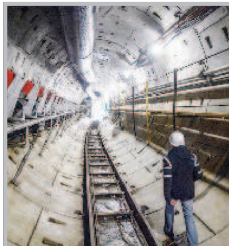
На северо-востоке Москвы метростроители построили левый перегонный тоннель Большой кольцевой линии на участке от камеры съез-
