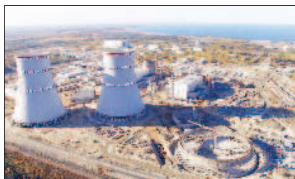
Продължава изграждането на атомната централа "Аккую" в Турция
