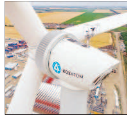
В Ставрополския край вече работи най-голямата вятърна електроцентрала в Русия. Снимка: "Росатом"
