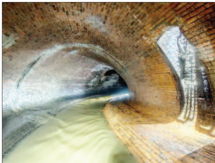
Участок подземного коллектора реки Неглинной, названный "Тропой Гиляровского"
