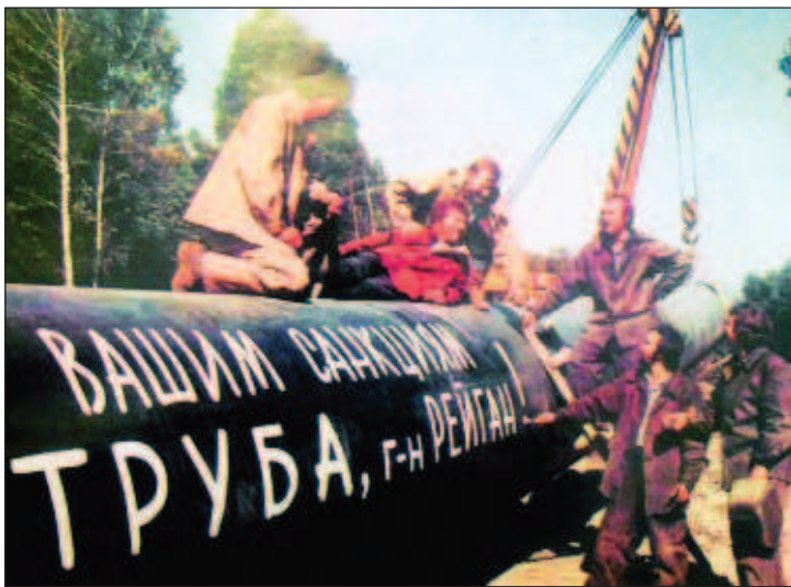
Советские монтажники пишут на секциях очередной нитки газопровода "Уренгой - Помары - Ужгород": "Вашим санкциям труба, господин Рейган!"
