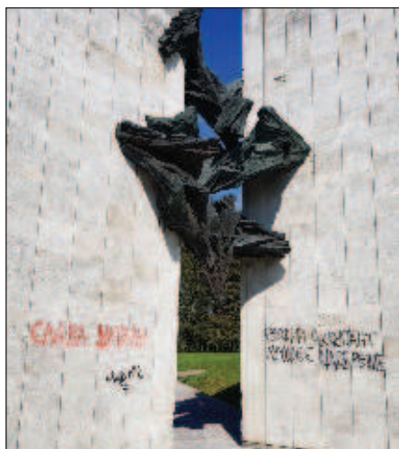
Оскверненная композиция "Гибнущие чайки"
