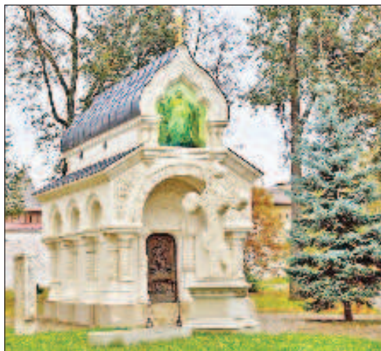
Часовня-усыпальница князей Пожарских в Суздале
