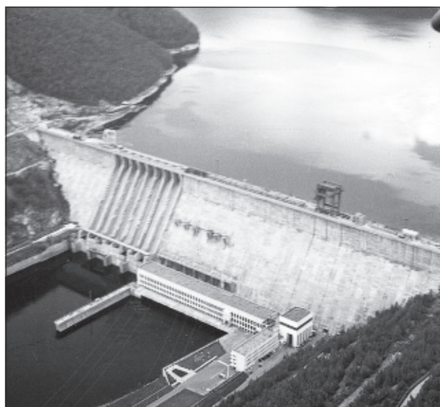
Всемирный банк дал своё согласие на строительство Рогунской ГЭС на реке Вахш в Таджикистане. Об этом сообщил заместитель главы Согдийской области Жумабай Сангинов на пресс-конференции в Худжанде, информирует Gezitter.org 15 августа с. г. Высота плотины Рогунской ГЭС - 336 м., строительство было запланировано еще во времена СССР
