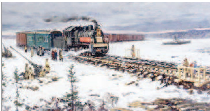
Строительство Дороги жизни
